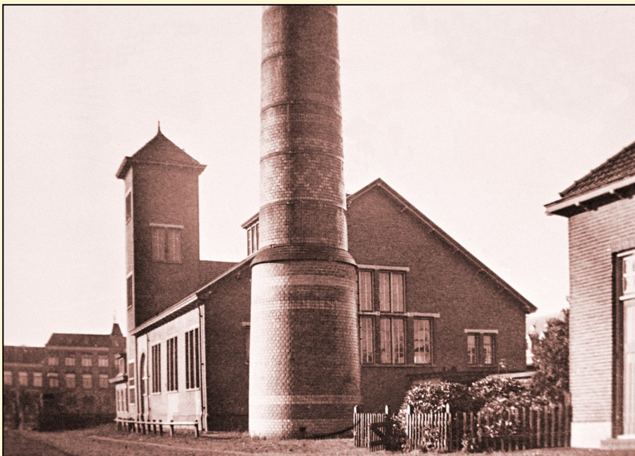
Gezicht op de schoorsteen met een hoogte van circa 35 meter en aan de basis een doorsnede van circa 4,5 meter. Foto P. Penneweert, circa 1937.
