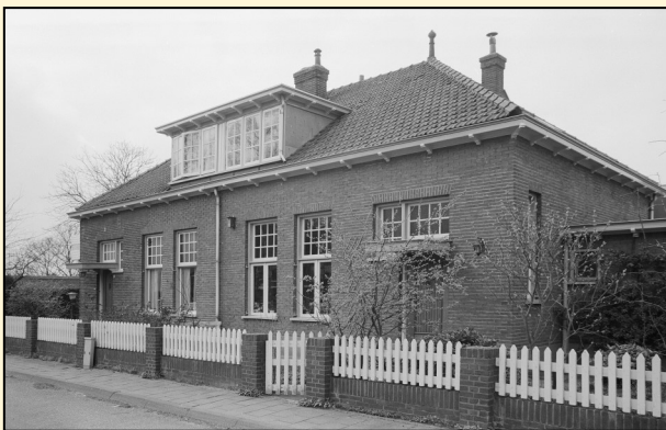
De twee dienstwoningen aan het Stationsplein (Spoorstraat). De rechtse werd in 1944 door een voltreffer grotendeels weggevaagd, maar in oude luister hersteld. Nog tientallen jaren woonde er personeel van NS, maar inmiddels zijn de woningen in andere handen overgegaan en samengevoegd tot één pand, zonder aantasting van de buitenkant. Foto Marius Broos, 20 maart 1991.
